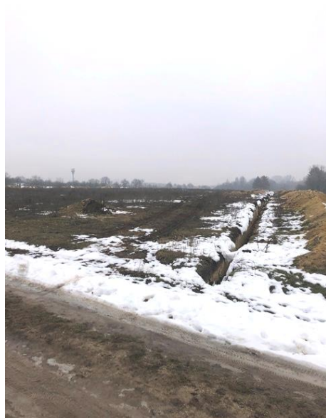
új parcellázású terület megkezdett közművesítés
