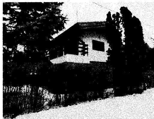
Földszint + emeletes épület
